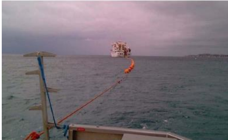
Figure 21 : Exemple de tirage d'un câble depuis un navire câblé vers la plage (Orange Marine)
