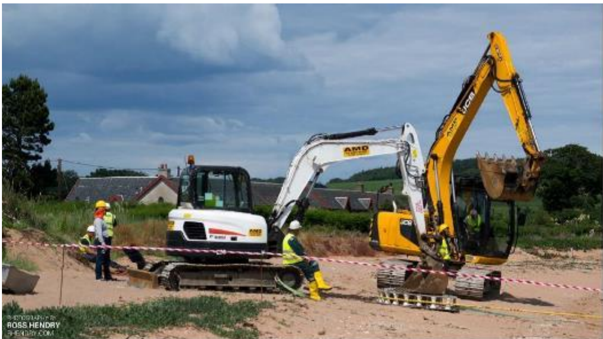
Figure 22 : Opération de tirage de câble avec deux pelleteuses et un quadrant (Orange Marine)
