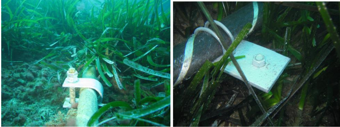
Figure 31 : Deux systèmes de fixation d'ancres à vis installées en zone d'herbier (photo : setec in vivo)
