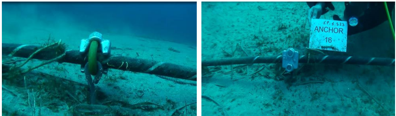
Figure 32 : Autre système de fixation du câble (Orange Marine)
